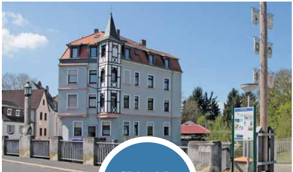
Blick auf die „Herrenmühle“.
