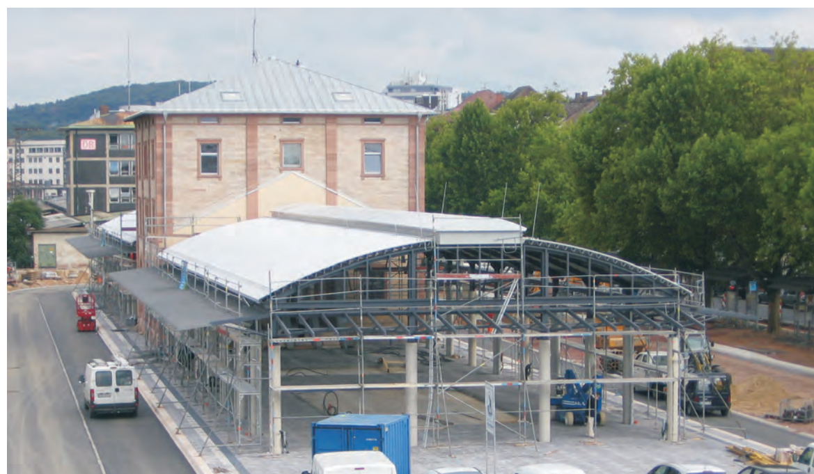
Blick vom Dammer Steg auf die Dachkonstruktion des neuen ROB
