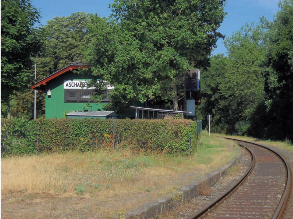
9) Bahnhof Aschaffenburg-Nilkheim – bis 1968: Schönbusch-Nilkheim – mit noch in Betrieb befindlichem Gleis (Aufnahme: Hans-Bernd Spies, Juli 2010).
