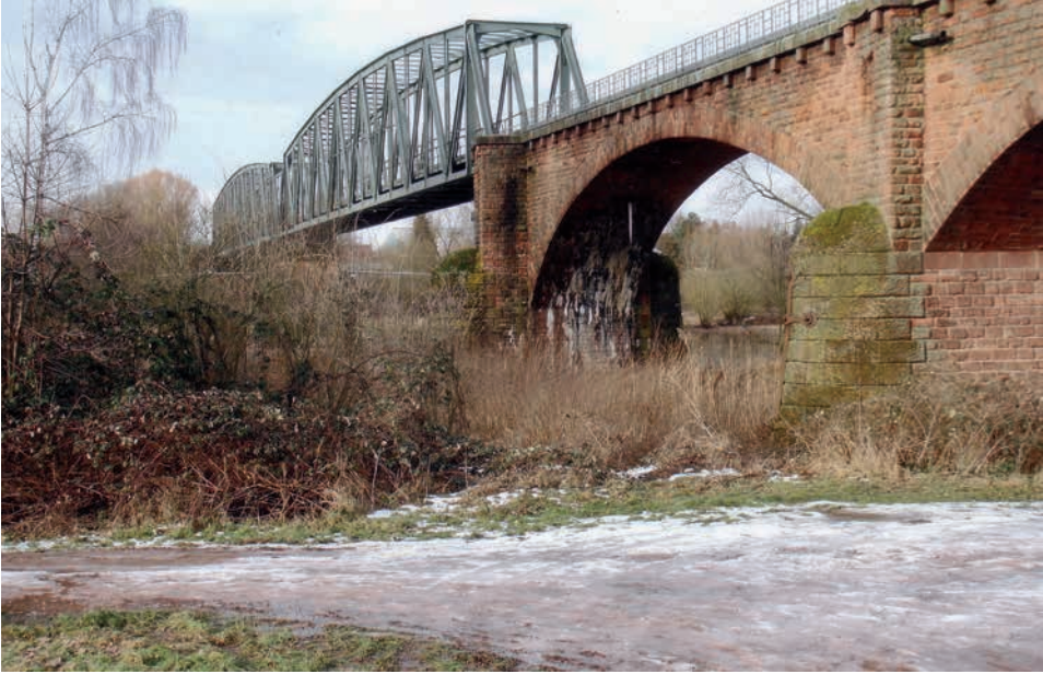
10) Nilkheimer Eisenbahnbrücke vom rechten Mainufer flußabwärts gesehen (Aufnahme: Winfried Staudt, Aschaffenburg, Februar 2010); der Schlußstein (Abb. 7) befindet sich in dem vorragenden Mauerwerk unterhalb der Metallkonstruktion.
