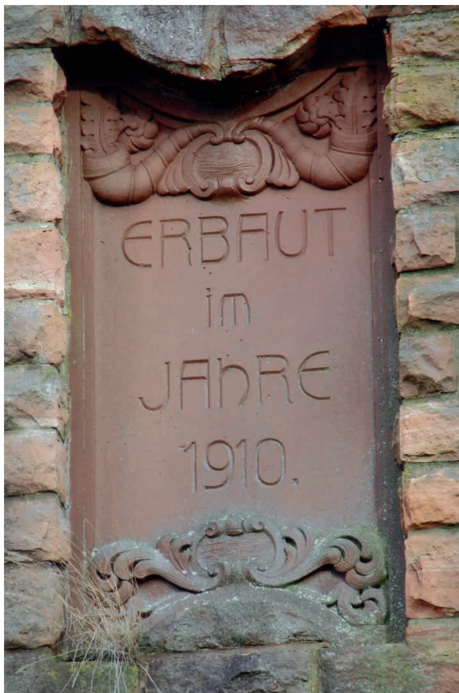
7) Schlußstein der Nilkheimer Eisenbahnbrücke (Aufnahme: Winfried Staudt, Aschaffenburg, Februar 2010).
