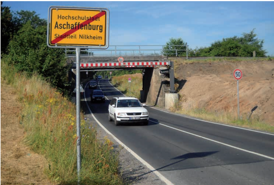
14) Unterführung der Großostheimer Straße unter die Bahn zur Eisenbahnbrücke (Aufnahme: Hans-Bernd Spies, Juli 2010).
