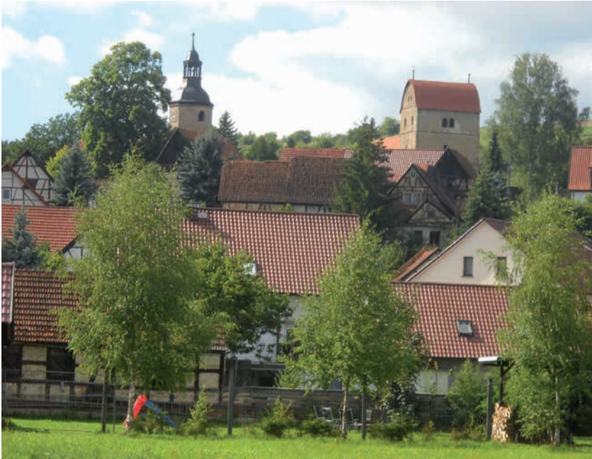
Rohr mit Torturm (links) der Kirchenburganlage und Kirchturm (rechts), Blick von Südosten (Aufnahme: Hans-Bernd Spies, 25. August 2010).
