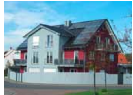
Neues Bauen im Stadtteil Obernau
