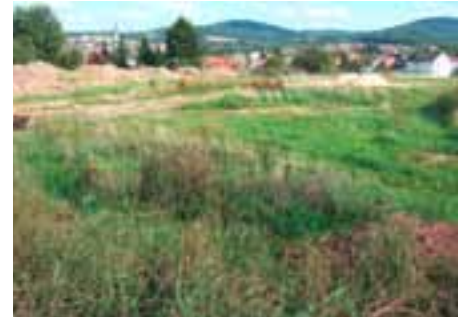
Bau der Erschließungsanlagen im Baugebiet „Gäbpfad“
