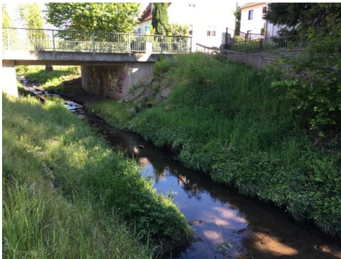
Abbildung 1: Einleitestelle in den Hensbach
