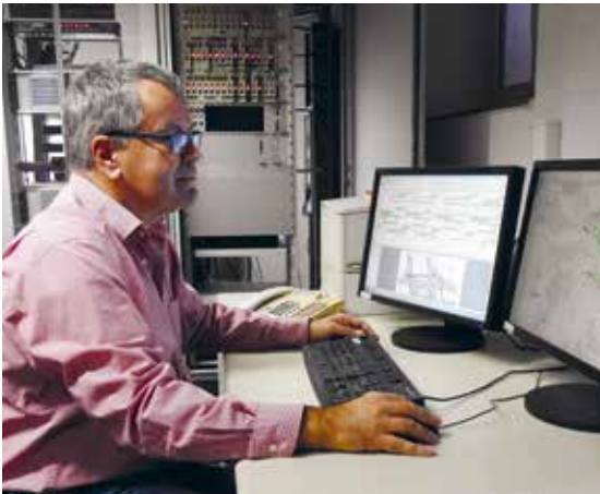
Uwe Winkler im Verkehrstechnikraum
