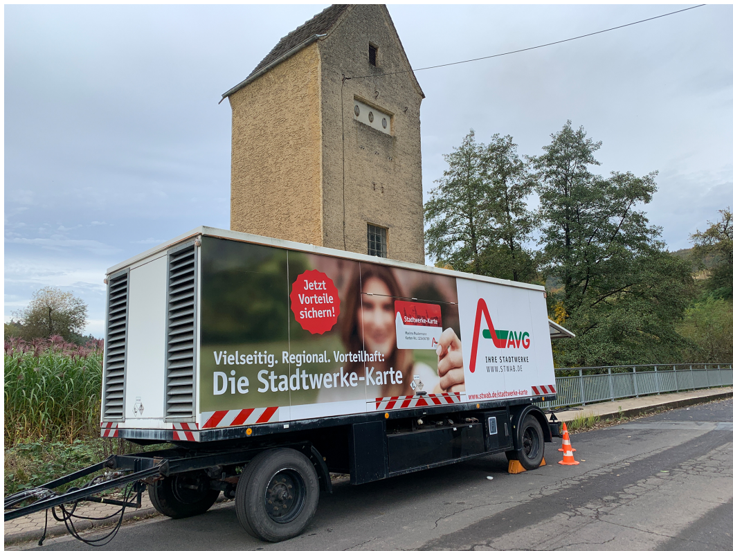
Bild 1: Notstromaggregat am Hahnenkammwerk, Foto AVG
