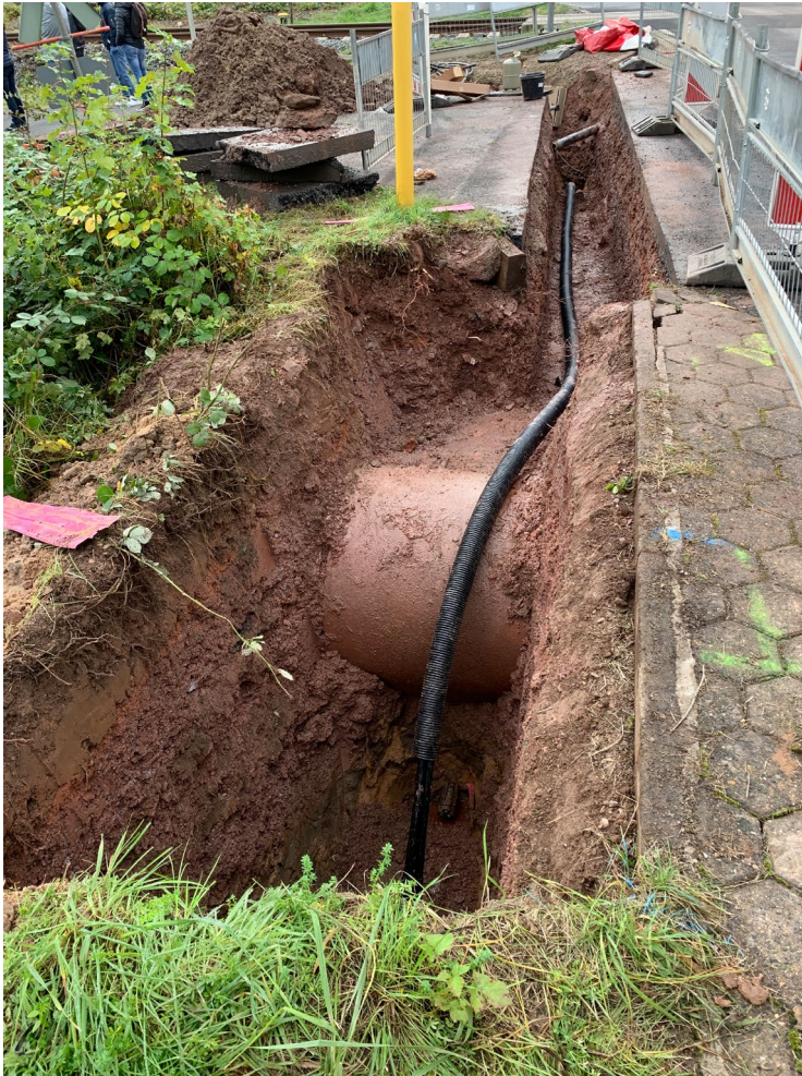
Bild 2: Reparatur des Kurzschlusses bei dem Erdkabel, Foto AVG
