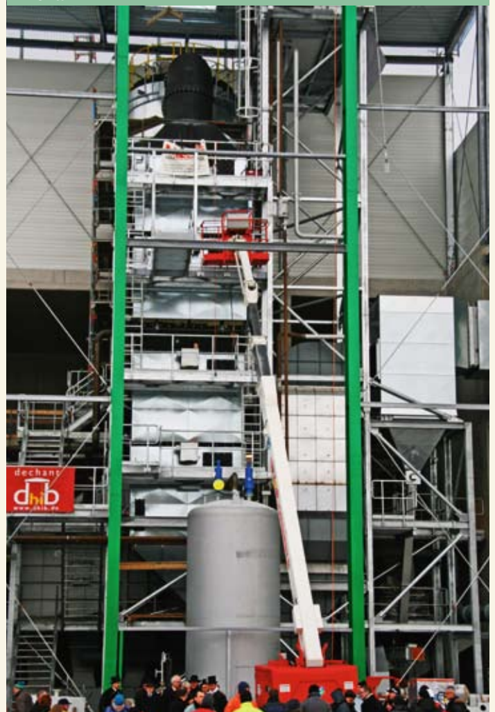
Das geöffnete Kesselhaus
