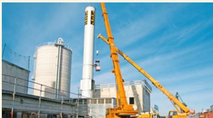
Montage des Abluftschornstein des Trockners
