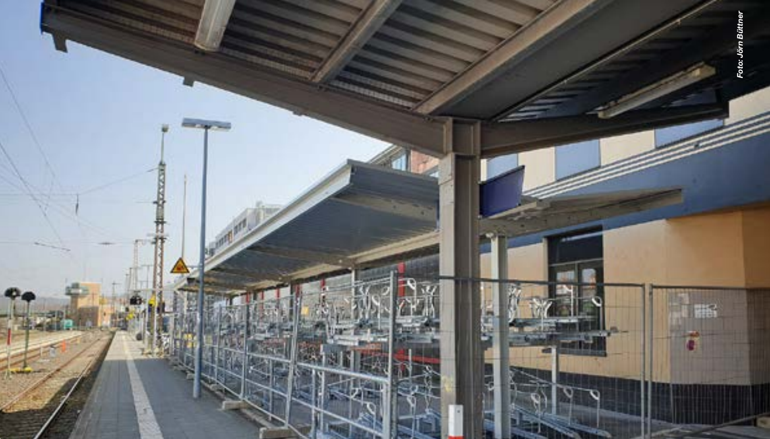
Die neuen Doppelstockparker an Gleis 1 während der Aufbauphase
