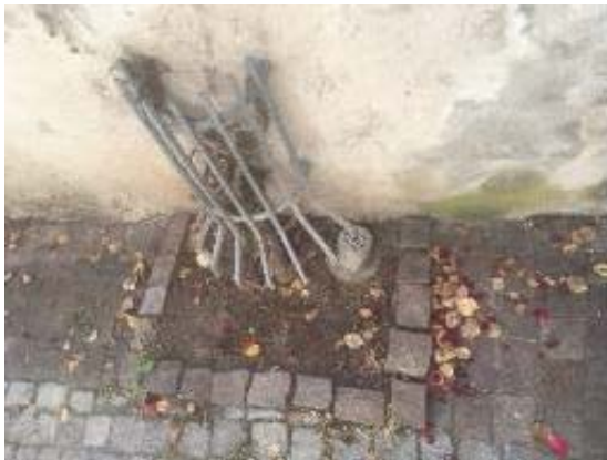
Abbildung 75: Gebäudefassade Aschaffenburg. Aufnahme: GreenAdapt 2020.
