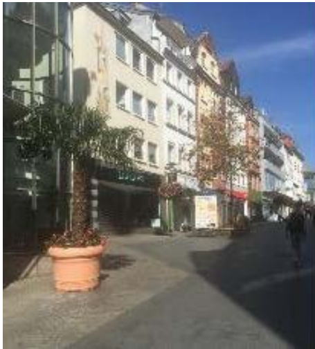
Abbildung 74: Innerstädtisches Gebäude in Aschaffenburg (GreenAdapt 2020)
