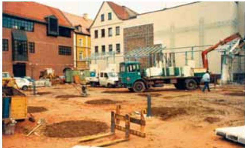
Der Wolfsthalplatz während der Umgestaltungsarbeiten, Dezember 1985.
