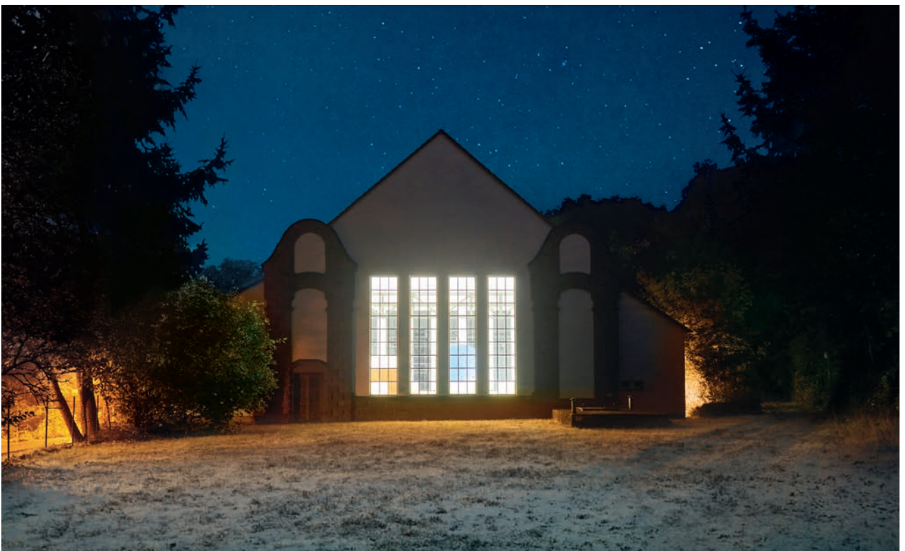
Das denkmalgeschützte Alte Wasserwerk in der Niedernberger Straße
