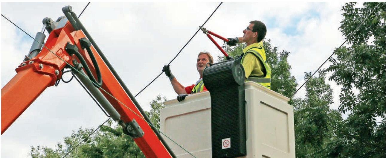
Rückbau der Freileitung in Hemsbach
