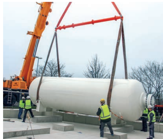
Montage des Wasserstofftanks auf dem Gelände der städtischen Verkehrsbetriebe
