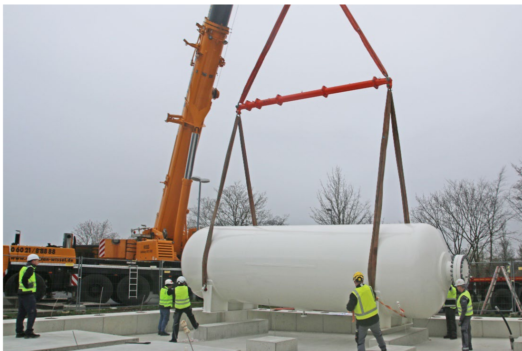
Bilder: Anfahrt und Montage des Wasserstoffspeichers im städtischen Verkehrsbetrieb, Foto Stadtwerke Aschaffenburg
